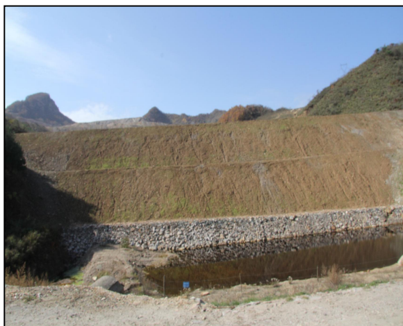
照片 2-4 拦渣坝工程治理效果
