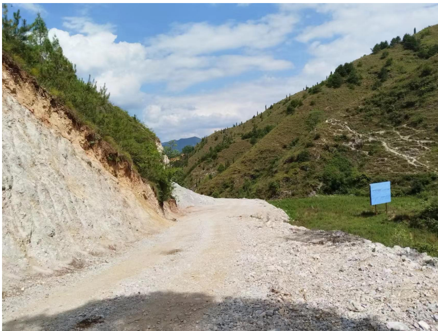
照片 3-3 现有矿山道路
