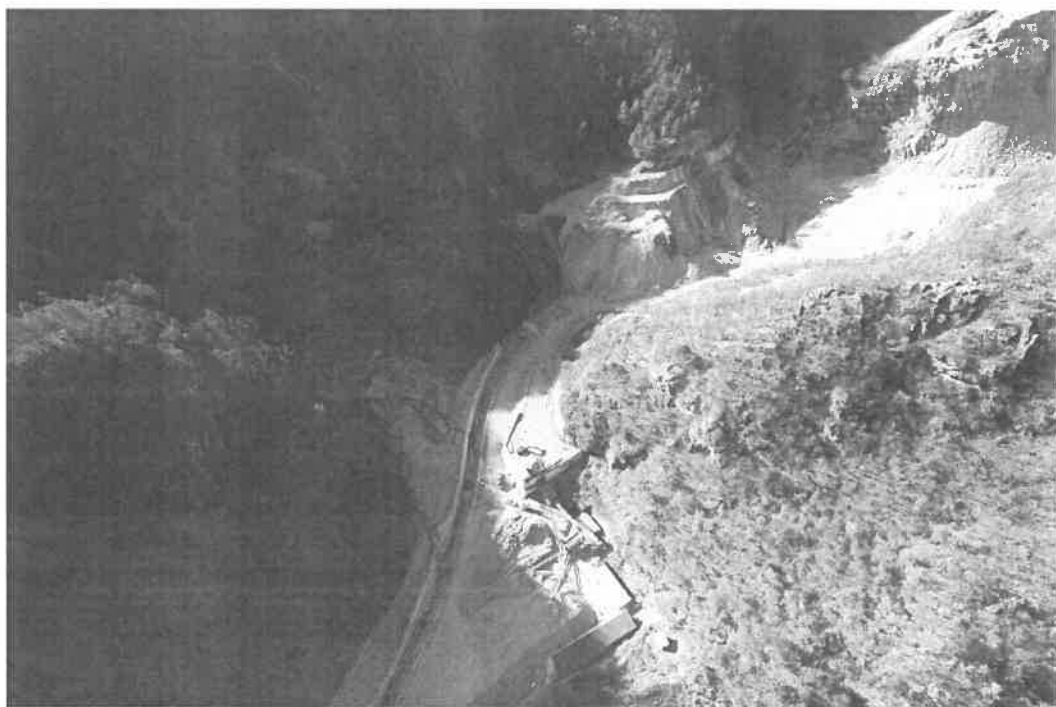
矿山现状 镜向 300° 照片 1-2
