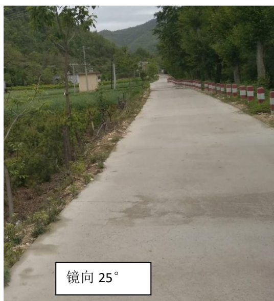
照片 1-4 通村水泥道路
