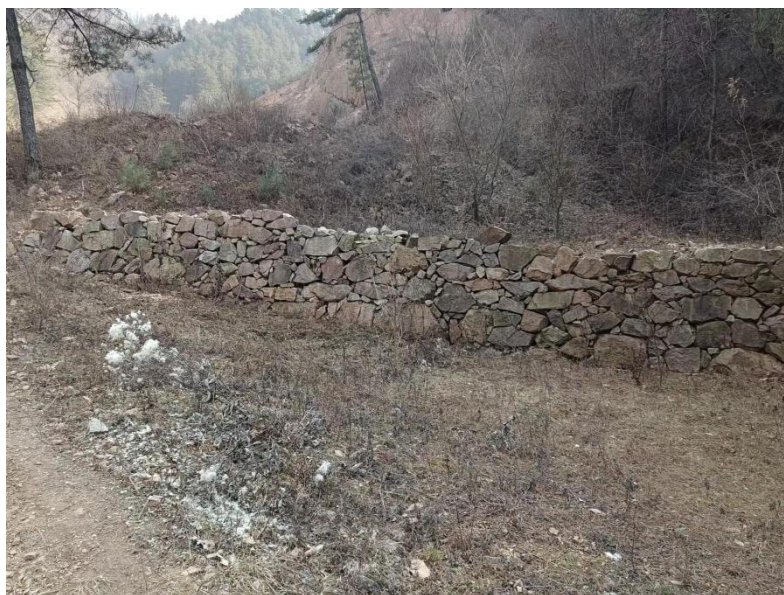
照片 2-5 表土临时堆场挡墙
