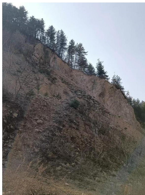
照片 1-7 废渣堆（镜向 150°）
