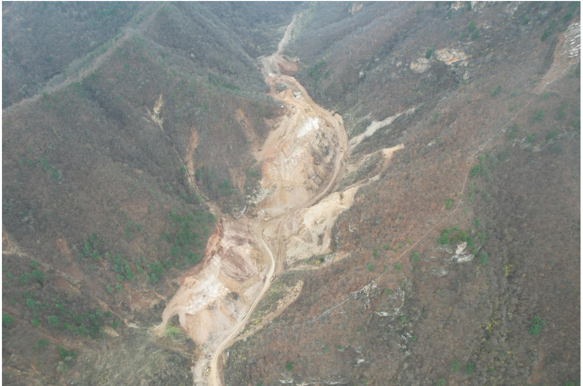
照片 3-8 K1-3 采区现状（含矿山道路、临时堆土场、露采掌子面）（镜向 263°）
