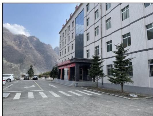
照片 2-7 办公楼照片
