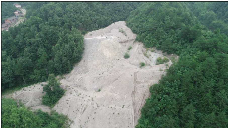
照片 2-4 Z1 临时堆渣场
