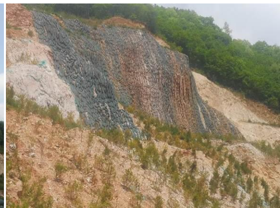
照片 7-4 矿区范围四主动防护网效果（镜向 320°） 拍摄时间：2024 年 4 月 27 日
