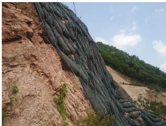
照片 7-3 矿区范围四主动防护网效果（镜向 45°） 拍摄时间：2024 年 4 月 27 日
