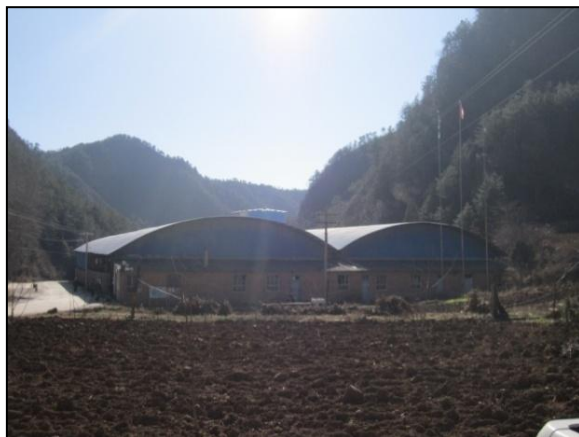
照片 1-7 西地沟工业场地（镜向 185°）
