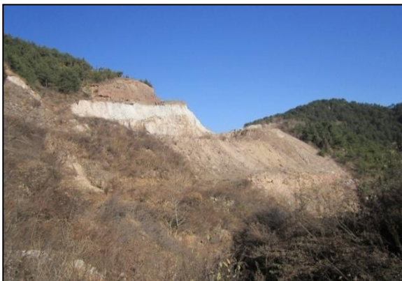
照片 1-5 废渣堆（镜向 47°）
