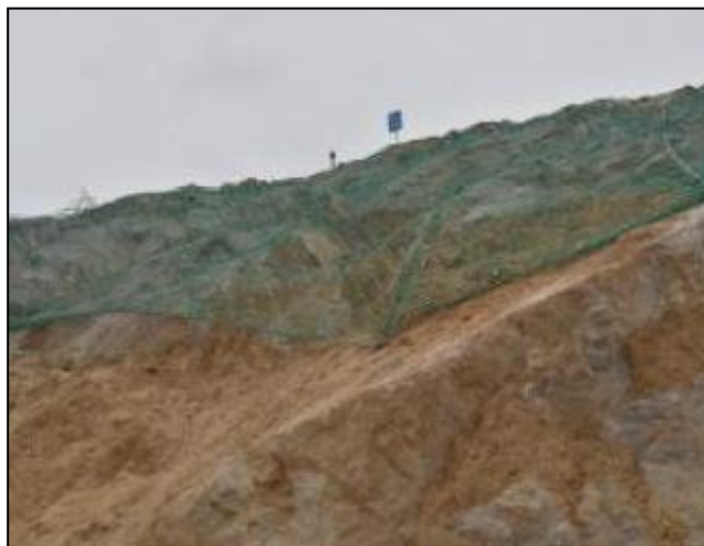
照片 2-8 采场边坡挂网防护
