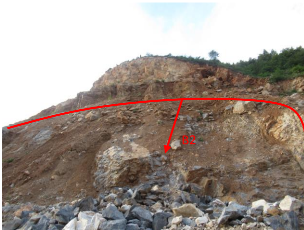
照片 3-2 崩塌（ B_2 ）隐患现状（镜向北）
