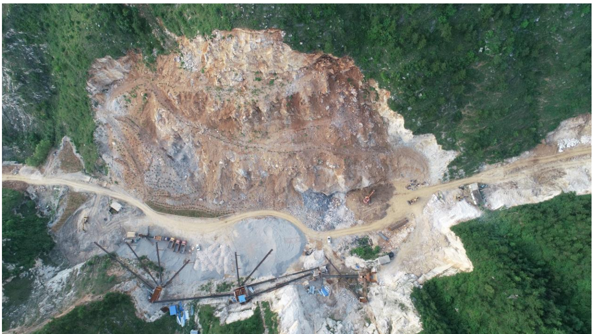
照片 3-2 露天采场及工业广场损毁林地、工矿仓储用地、交通运输用地现状（镜向北）
