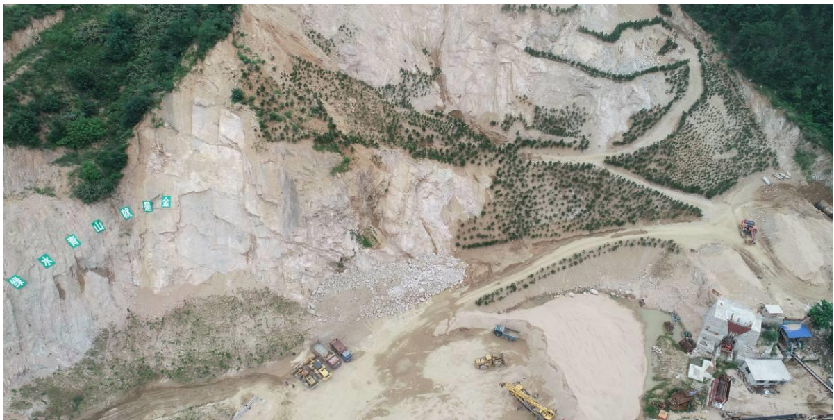
照片 2-21 露天采场恢复治理效果（镜向西南）
