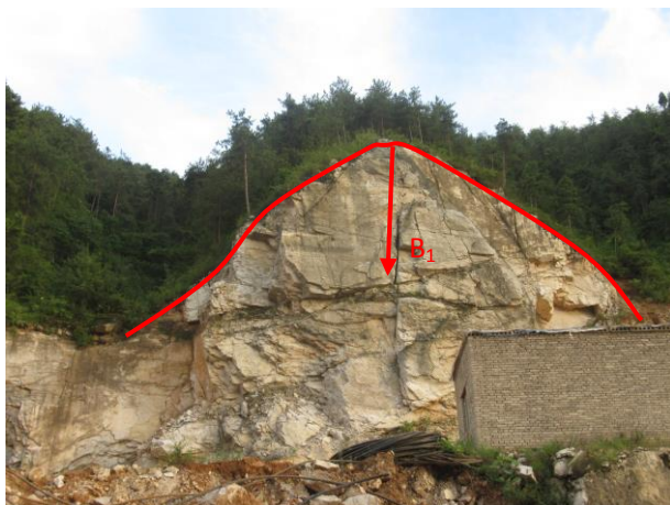
照片 3-1 崩塌（ B_1 ）隐患现状（镜向南）
