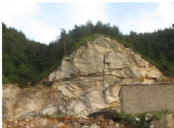
照片 2-20 采场边坡灾害防治（镜向南）
