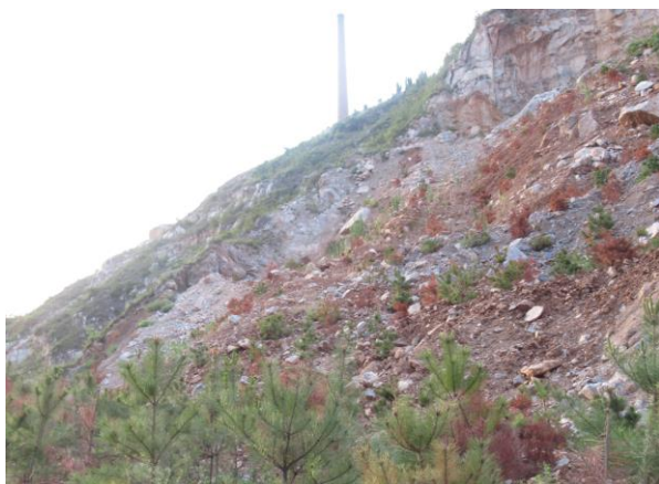
照片 2-19 采场边坡绿化（镜向北）
