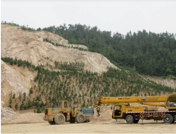
照片 2-22 采场复绿现状（镜向东南）
