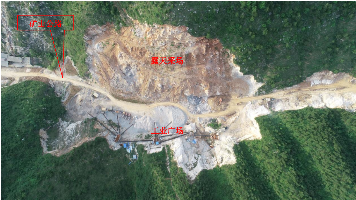
照片 3-3 早期露天采场、矿山公路、工业广场（镜向北）
